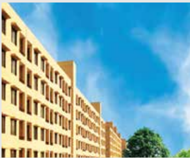
Anant Raj Aashray, Neemrana, Rajasthan
