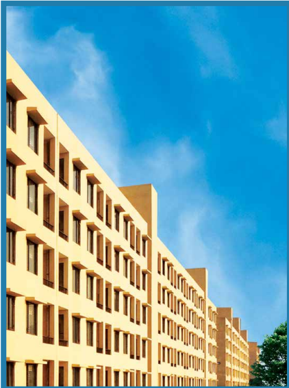
Anant Raj Aashray, Neemrana, Rajasthan
